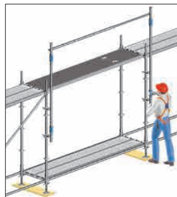
Fig. 18 Anvendelse af MSG i opgangsfeltet
